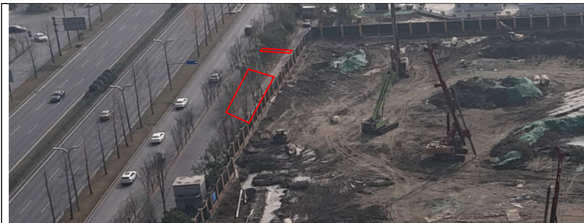
图 3-4 场外衔接工程区现状照片
