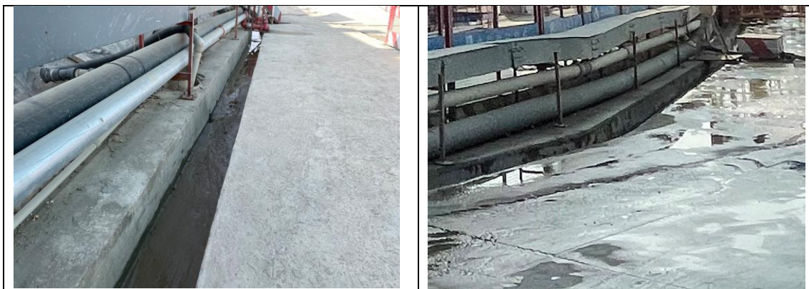
图 3-1 主体工程区施工期间照片
