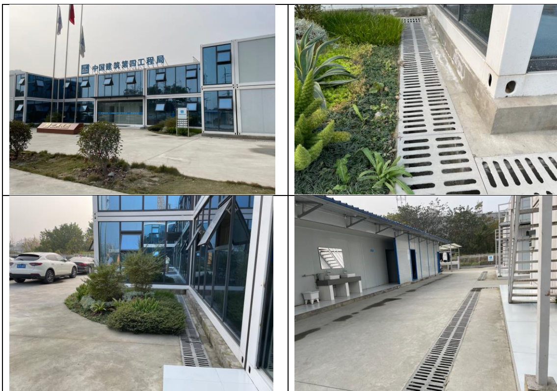
图 3-2 施工办公区现状照片
