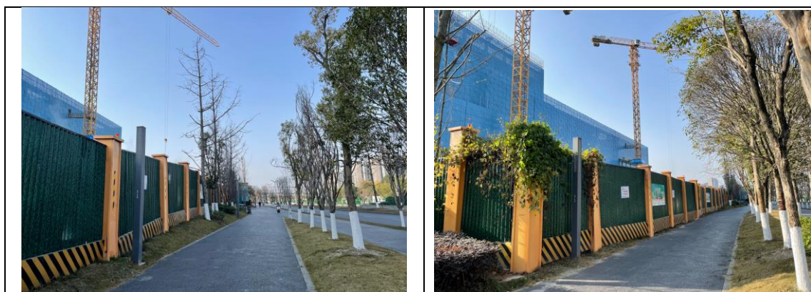
图 3-4 场外衔接工程区现状照片
