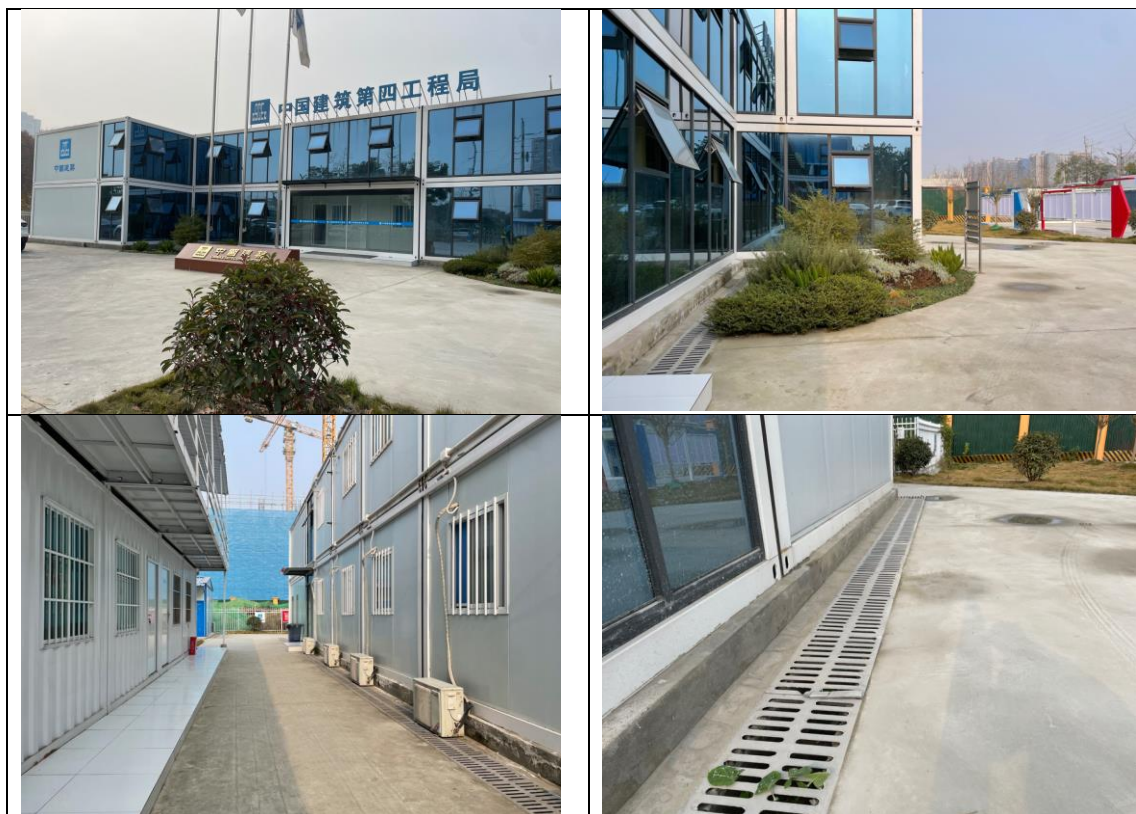
图 3-2 施工办公区现状照片
