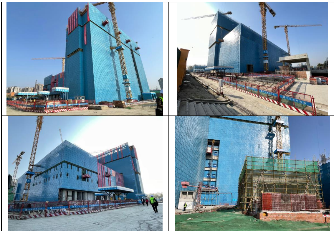
图 3-1 主体工程区施工期间照片
