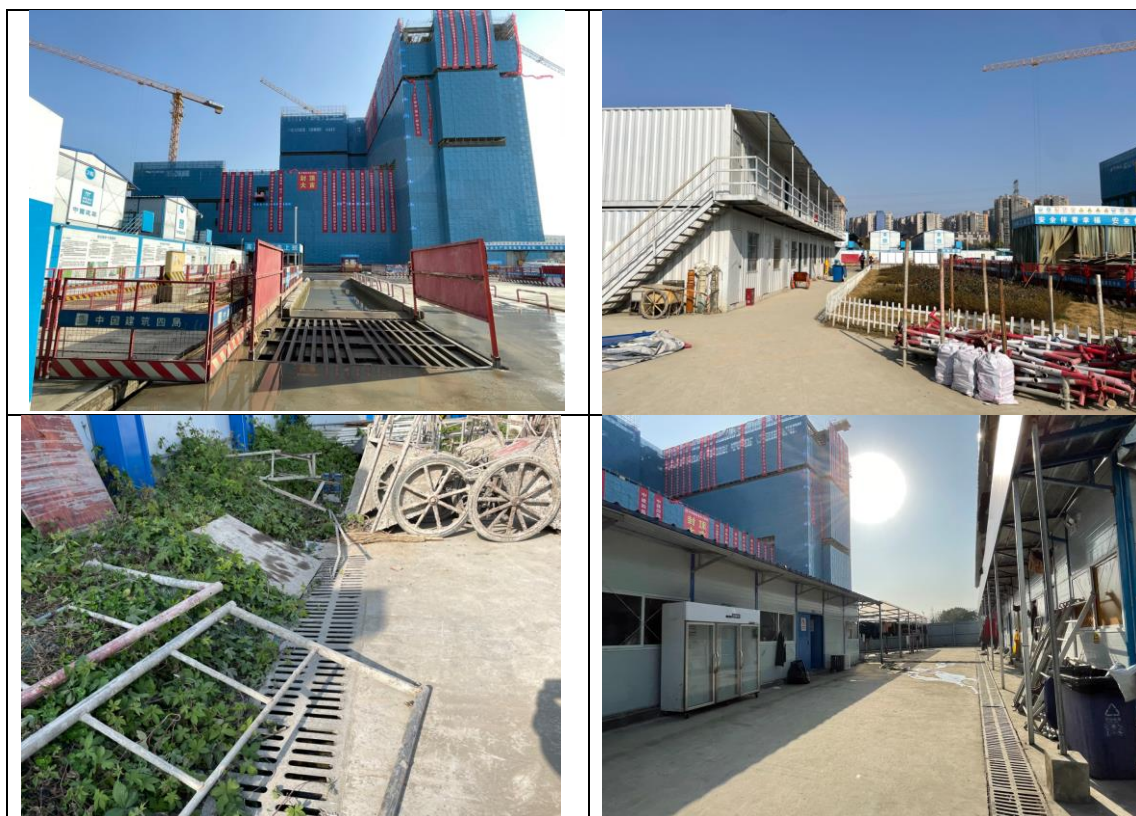
图 3-3 施工生产生活区现状照片
