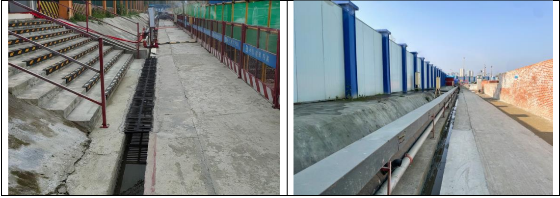
图 3-1 主体工程区施工期间照片
