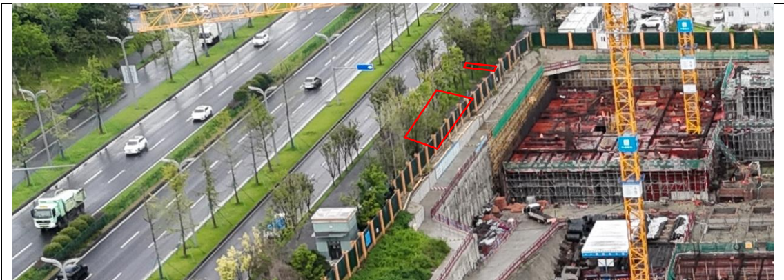
图 3-4 场外衔接工程区现状照片
