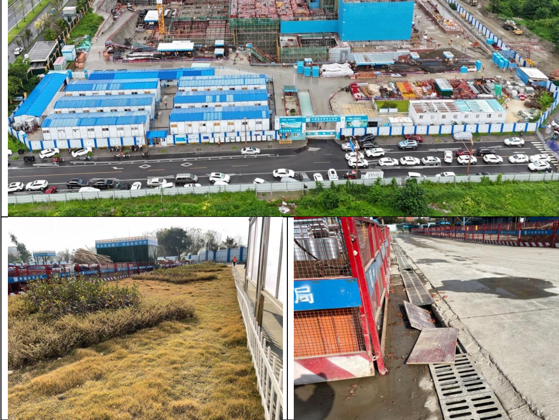
图 3-3 施工生产生活区现状照片
