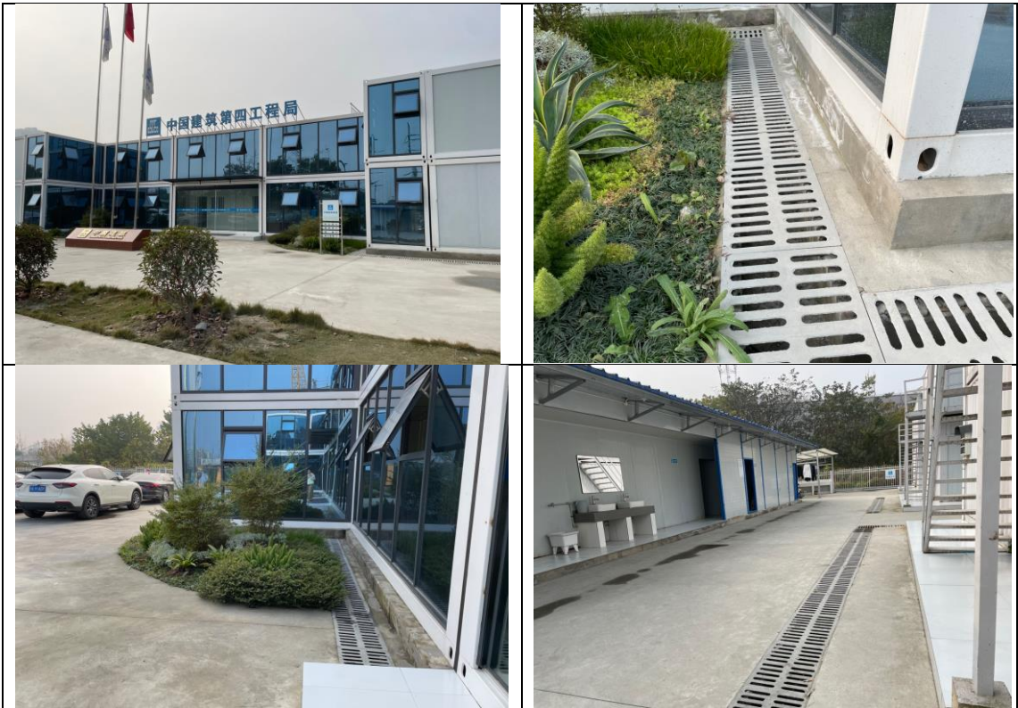
图 3-2 施工办公区现状照片
